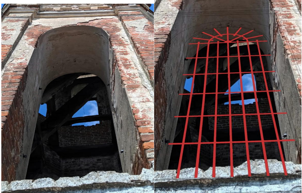
Рис. 2 Восстановление рисунка решетки по сохранившимся следам.
