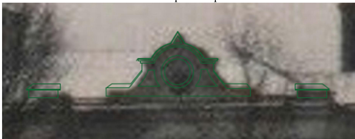
Рис. 5 Восстановление формы аттика по фотоматериалам 1941 года
